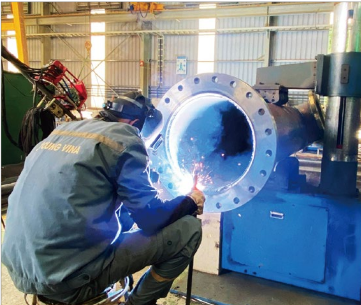
스틸 배관 제작 공장
